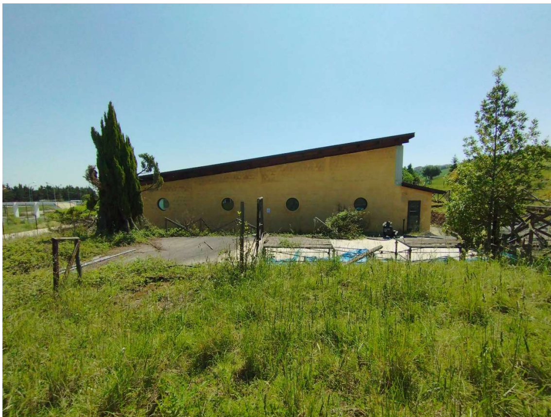
Foto n.6 – Vista prospetto ovest.
