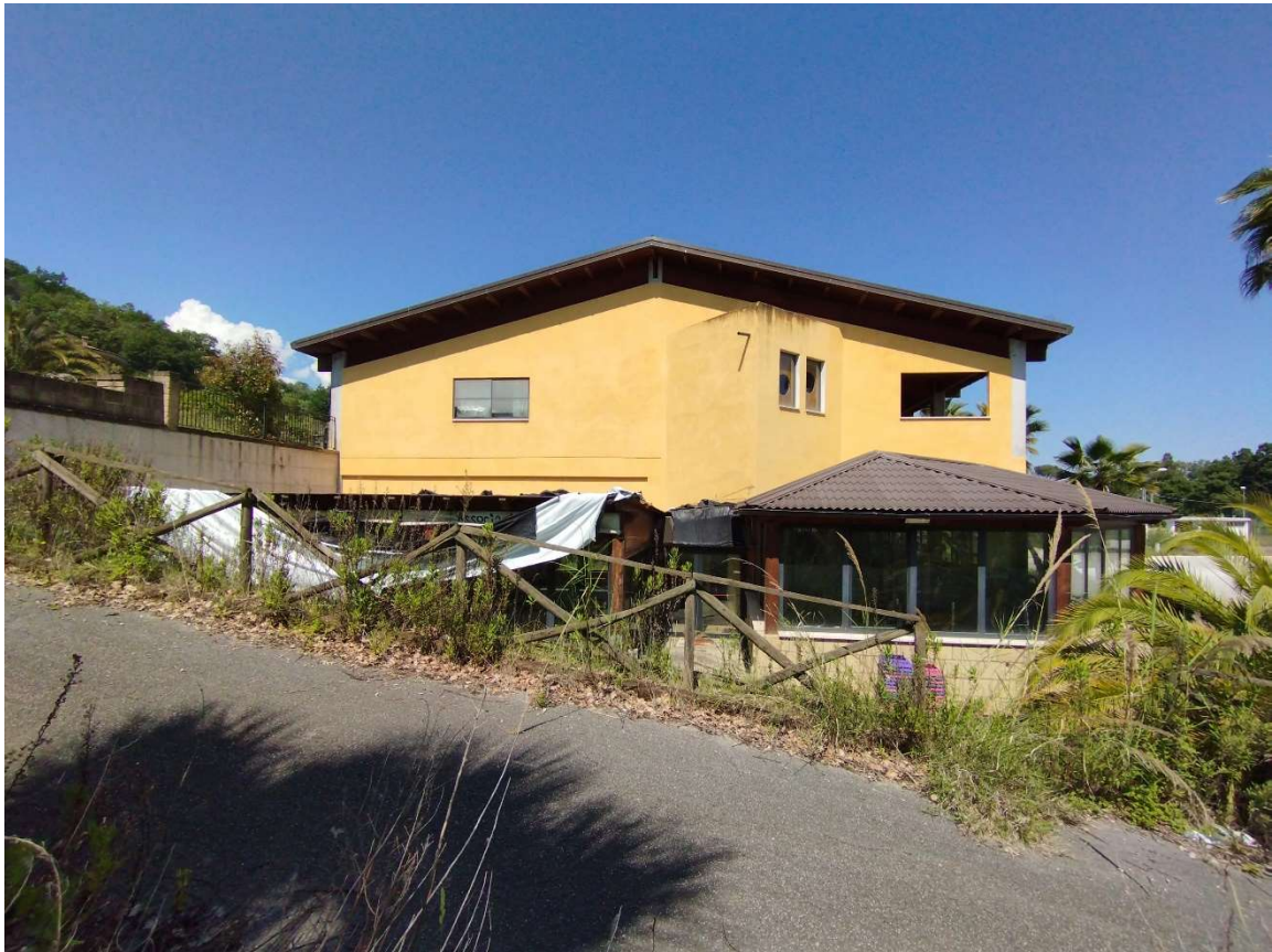
Foto n.3 – Vista prospetto est.
