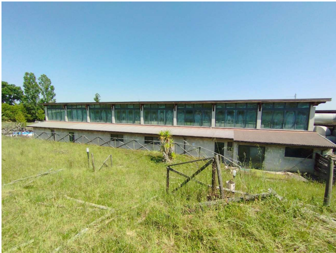
Foto n.5 – Vista prospetto sud.
