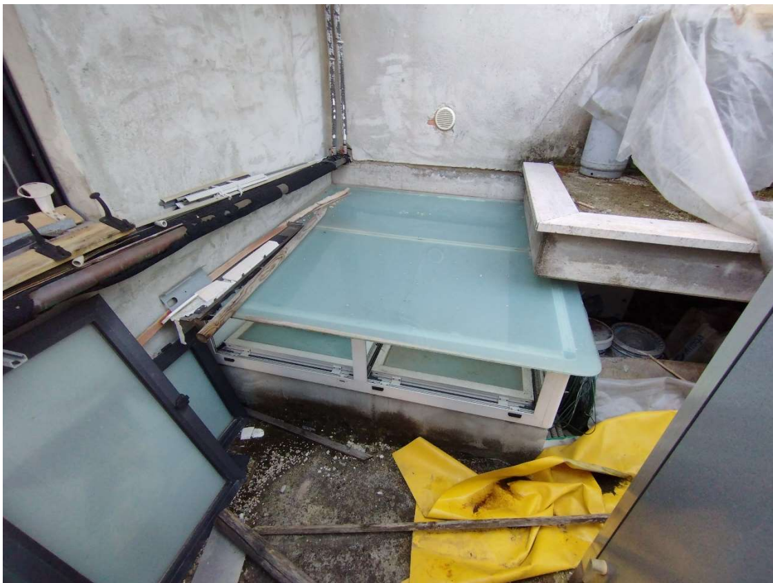
Foto n.7 – Vista esterna lucernaio esistente.
