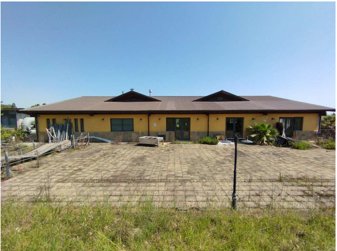
Foto n.4 – Vista prospetto sud.
